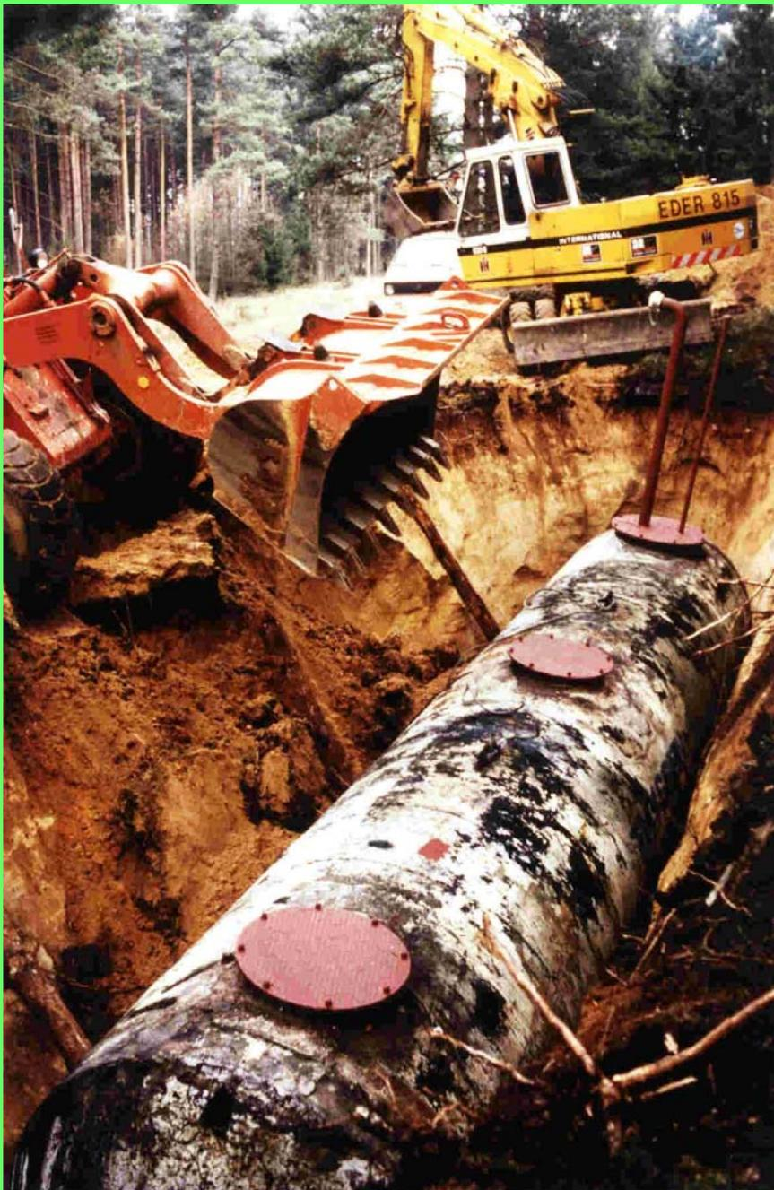
Zusätzlich wurden – insbesondere in den Landes-Forsten – in den letzten 20 Jahren über 50 große Erdtanks mit 20 bis zu 100 cbm Inhalt als Löschbehälter in die Nähe gefährdeter Kiefernflächen eingebaut. Das Bild zeigt den Einbau eines 30 cbm großen ehemaligen Treibstofftanks, der nach Reinigung und Entgasung als Löschwasserbehälter im Nds. Forstamt OERREL das Waldbrandrisiko verringern helfen soll.
